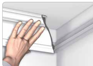
Befestigen Sie die Zierleiste auf der Schiene und an der Decke
