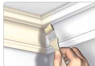
Überstreichen Sie die Zierleiste in der gleichen Farbe wie die Wand und/oder die Decke.
